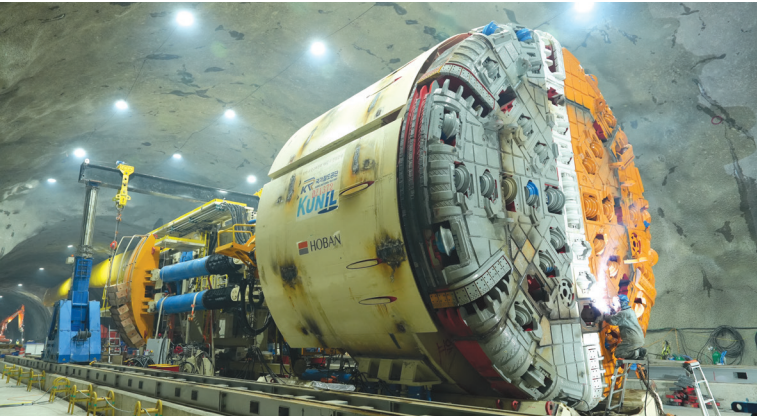
평택~오송 2복선화 제4공구 건설공사(터널)
