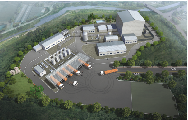
10MW급 저온 수전해 수소 생산 및 출하시설
